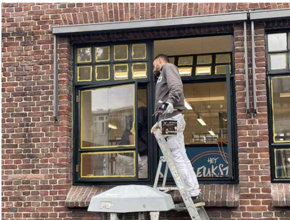
Schilderwerk aan het Wyt-gebouw na terugplaatsen van de kozijnen
