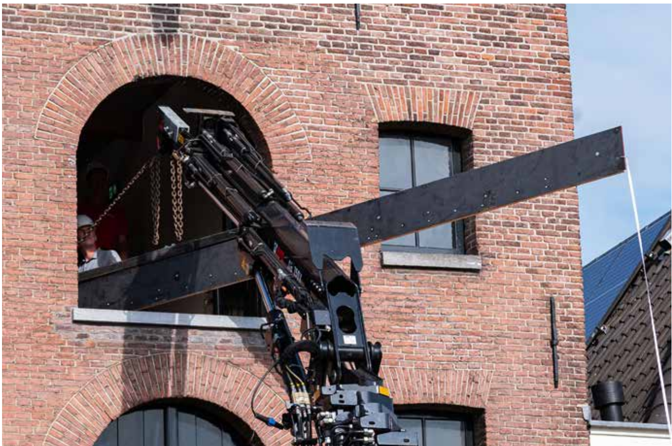
Hijsen van stalen balken t.b.v. glazen vloer Dubbele Palmboom
