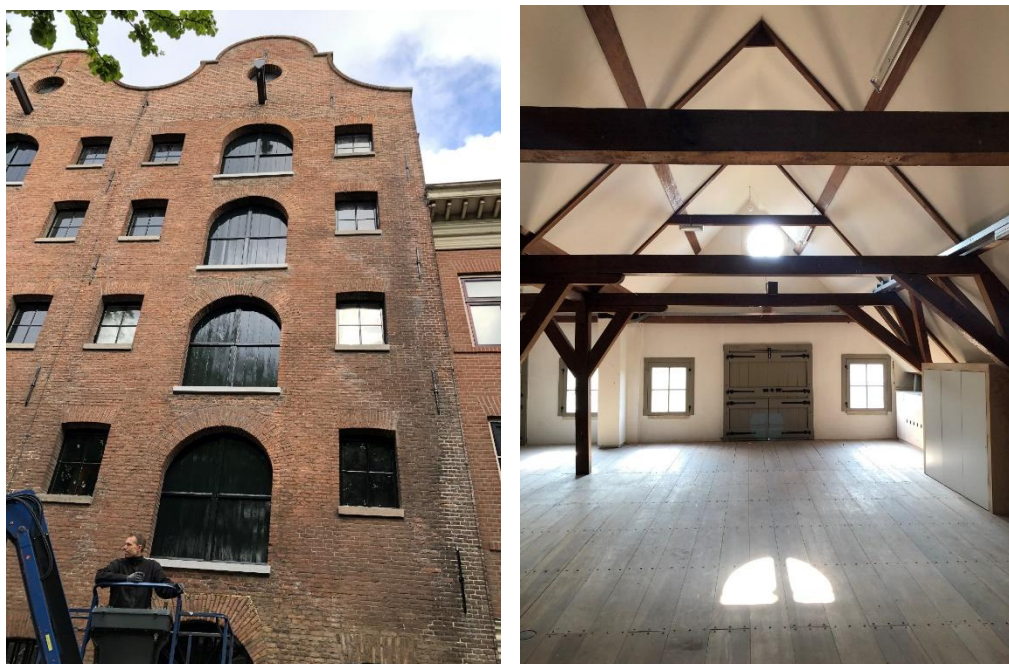
Schilderwerk afgerond buitenzijde en zolderkap geïsoleerd en tevens kozijnen en luiken geschilderd
