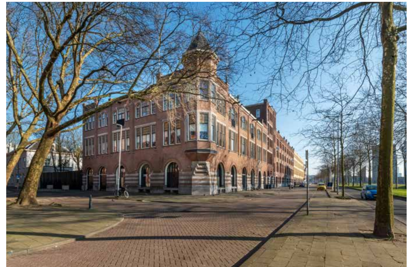
Voormalige pepermuntfabriek aan de Westzeedijk
