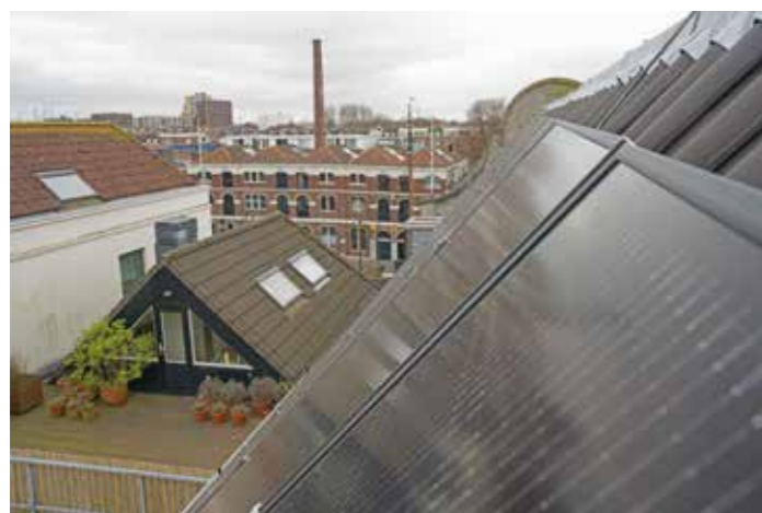
Geplaatste zonnepanelen Voorhaven 57 (boven) en Dubbdelde Palmboom (onder)
