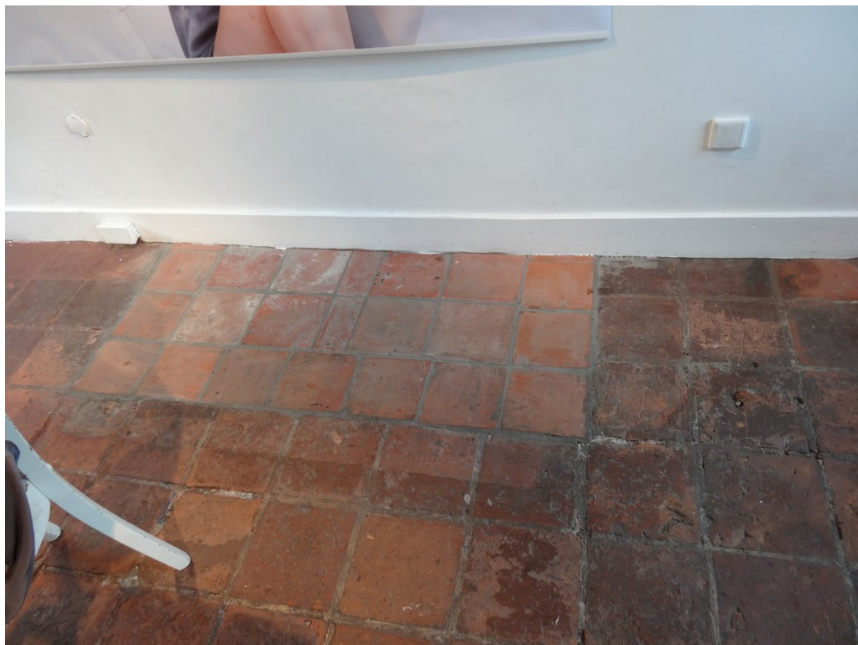
Afb. 29: Tegelvloer tegen de zuidelijke muur, waarin afwijkende tegelmaat is verwerkt. In dit veld was de oven van de tingieter geplaatst, zie afb. 16.
