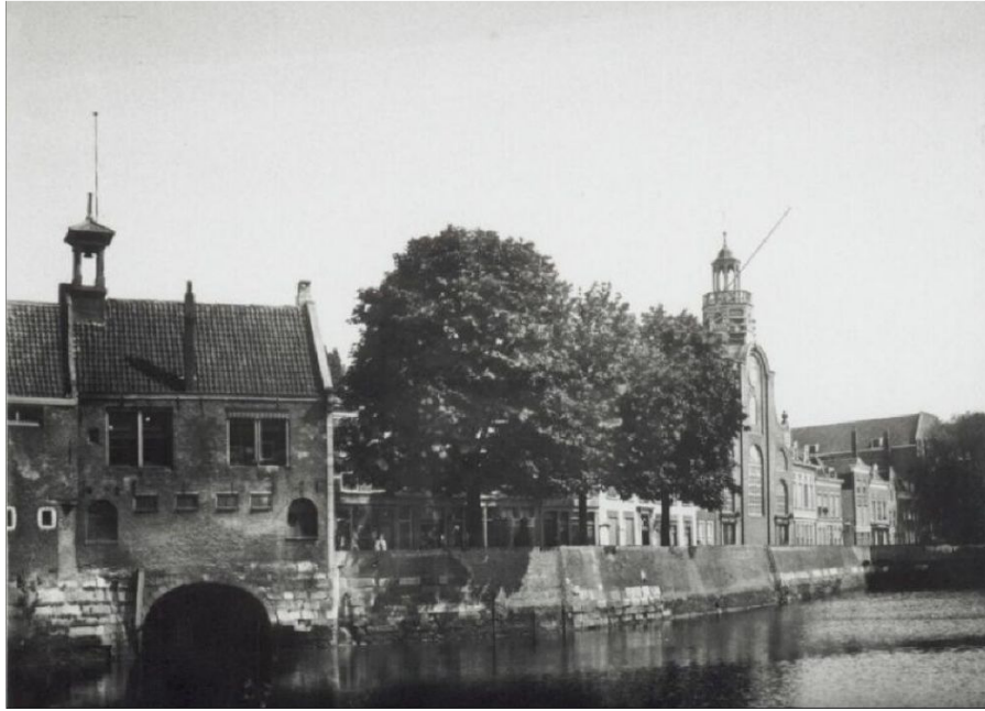
Afb. 11: Kolkzijde van het Kraanhuis omstreeks 1910. In plaats van de rondboogvensters zijn de gekoppelde 6-ruits vensters aangebracht.
