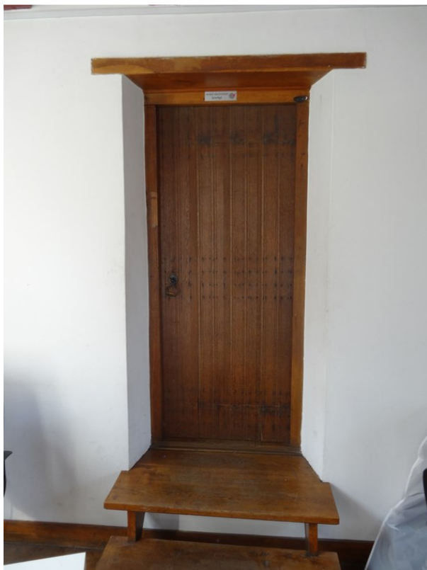
Afb. 43: Toegangsdeur naar de tweede bouwlaag van het Kraanhuis. Zie ook afb. 31
