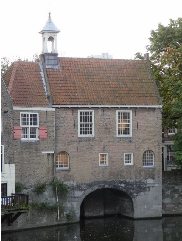
Afb. 25: Westelijke gevel van het Zakkendragershuisje en het Kraanhuis. Op de overkluizing van Naamse Steen is een bakstenen gevel, waarin verschillende baksteensoorten en herstellingen herkenbaar zijn, zie afbeelding 27.
