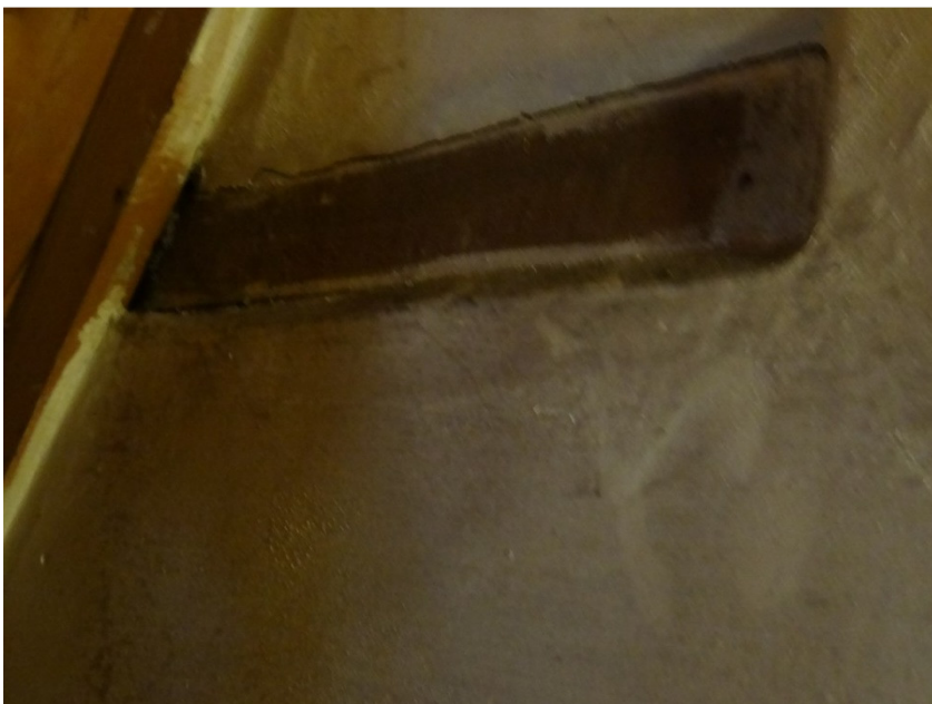
Afb. 37: Eikenhouten latei in de noordelijke topgevelmuur. Geheel links is de stijl van de dakruiter zichtbaar.
