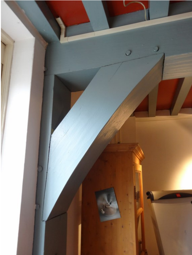
Afb. 32: Detail van een geschoorde moerbint op muurstijl.
