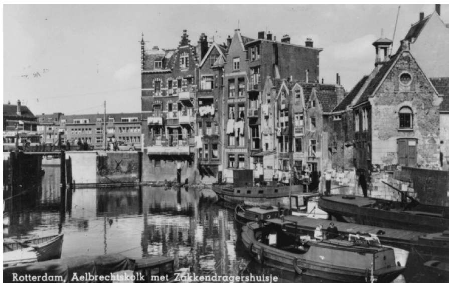
Afb. 12: Aanzicht vanuit het zuiden in 1948 met geheel rechts het Kraanhuis, waarvan de zuidelijke gevel vrijwel de gehele pleisterlaag is verloren. Aan weerszijden van het rondvenster inde topgeel zijn twee verticale dichtzettingen zichtbaar.
