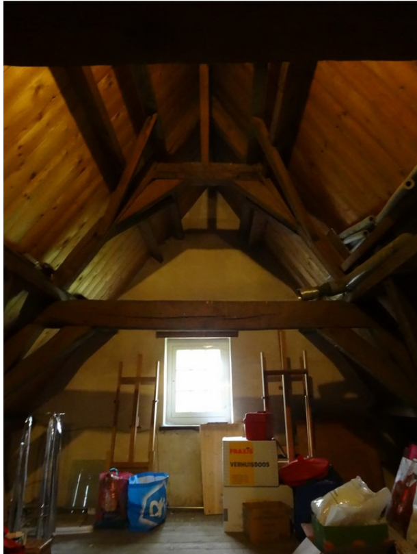
Afb. 34: Kapconstructie op de zolder, gezien naar het zuiden met de eikenhouten dekbalkjukken en A-spanten, grenenhouten flieringen en wormplaten. Over deze constructie is tijdens de restauratie een gordingenkap met beschot aangebracht.
