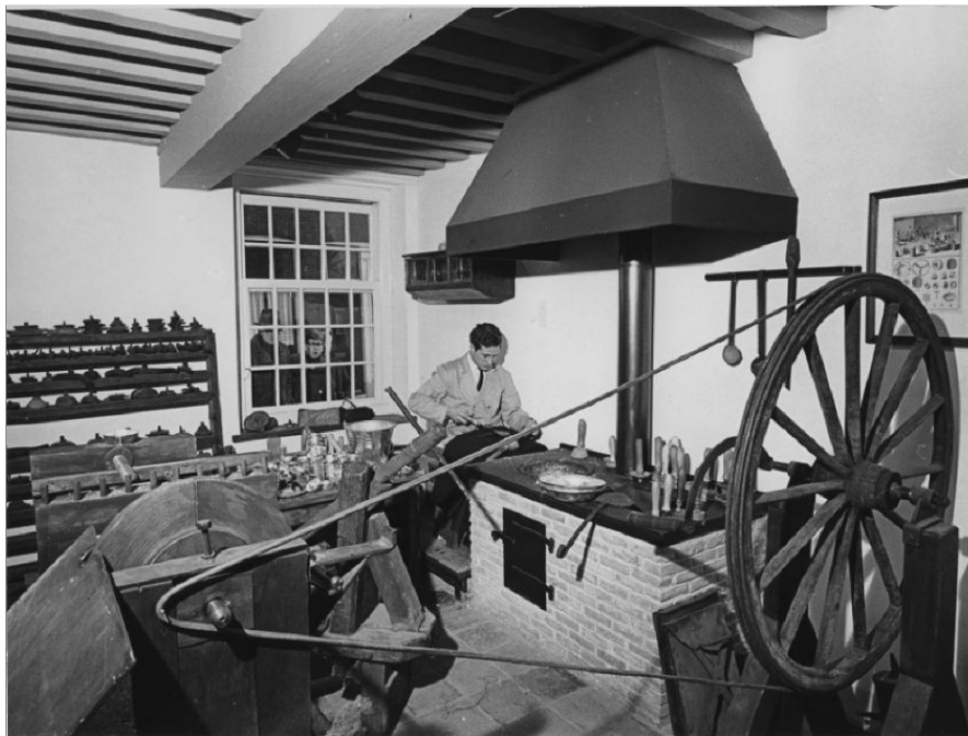
Afb. 16: inrichting van de eerste bouwlaag als tingieterij. Tegen de zuidelijke muur is een oven met rookgasafvoer en schouwboezem geplaatst.
