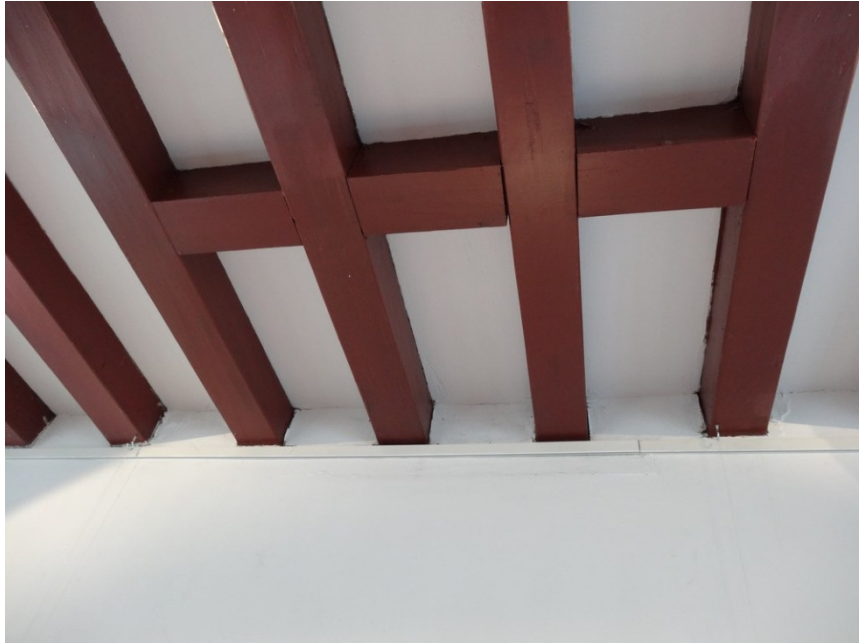
Afb. 30: Klossen tussen de kinderbinten, die zonder randligger opgelegd zijn in de zuidelijke muur. Onder de opeleggingen is een (wit geschilderde) latei aanwezig, waaronder de uitloop van de rookgasafvoer moet zijn aangebracht. De klassen geven de bovenrand van de (metalen) schouwboezem aan, zie afb. 16.
