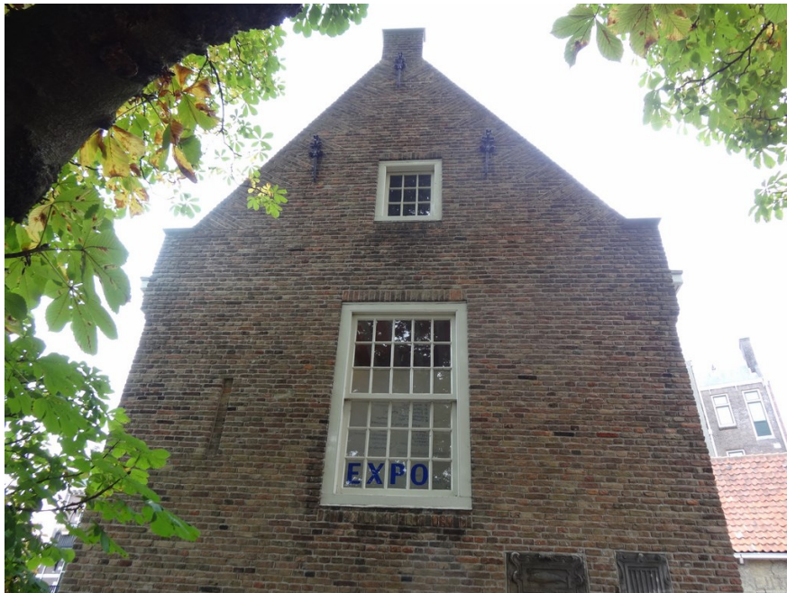
Afb. 23: zuidelijke gevel Kraanhuis. In de topgevel de andere rijk bewerkte ankers. Naast het 30-ruits schuifvenster is de smalle dichtgezette spleet zichtbaar. Aan de onderrand van de foto zijn twee van de vier ingemetselde gevelstenen zichtbaar.
