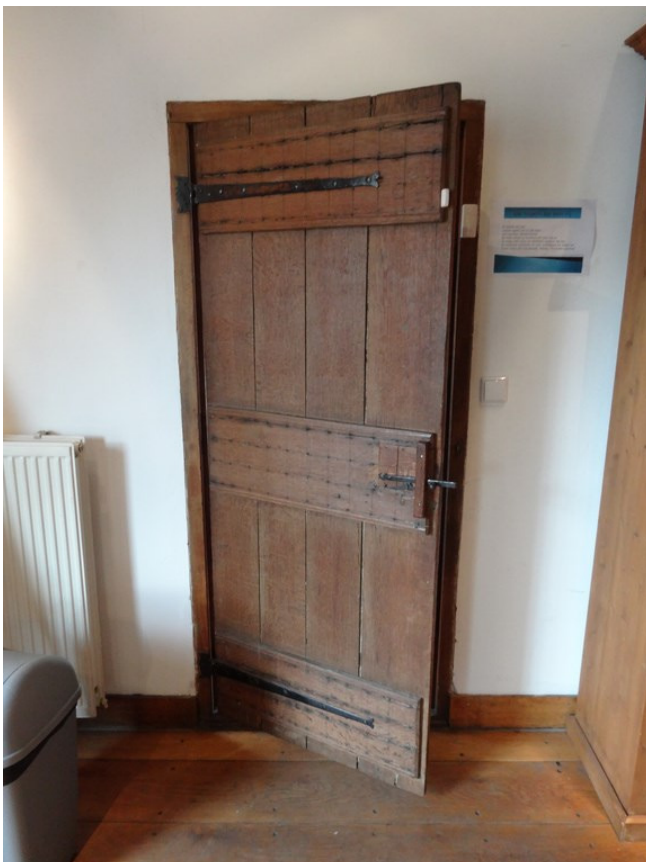
Afb. 33: Binnenzijde van een eikenhouten opgeklampte deur, mogelijk 17 e -eeuws. De klampen zijn voorzien van kraslijnen, waarlangs het nagelpatroon is uitgezet, zie ook afb. 43
