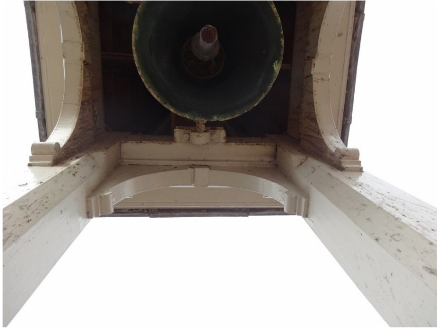
Afb. 38: Onderzijde van de open dakruiter, dat een product is van de uit 1964 daterende restauratie.
