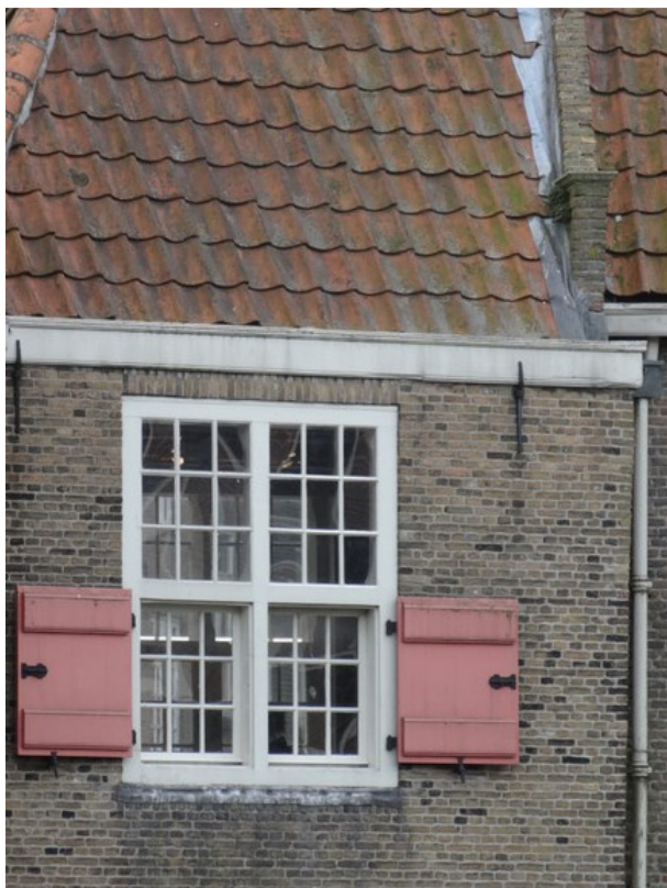
Afb. 26: Kruisvenster in de westelijke gevel van het Zakkendragershuisje. De rodenverdeling in de bovenlichten is direct op het kozijnhout bevestigd.
