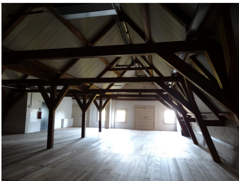
Afb. 42: Kapconstructie op de zolder met negen dekbalkjucken elk ondersteund door een standvink. Op de dekbalk twee A-spanten, die de dubbele gordingkap dragen.
