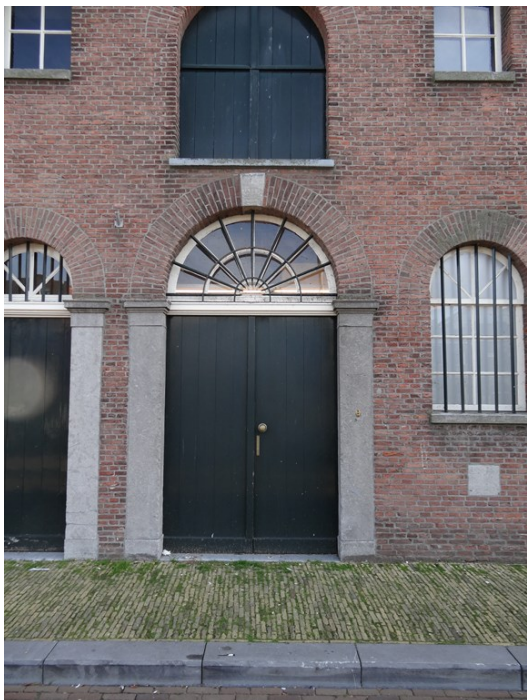
Afb. 17: Gevel voorhaven met de noordelijke poort met de sluitsteen 1861. De smalle poort is tijdens de restauratie aangebracht, ook met hardstenen pilaren en een naar buiten draaiende deur.
