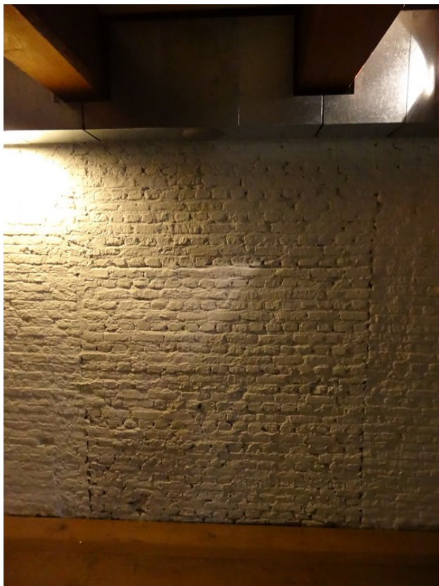
Afb. 37: Dichtzetting aan de zuidelijke zijde van de vierde bouwlaag. De randen van het oudere metselwerk zijn behakt om muren te kunnen aansluiten.
