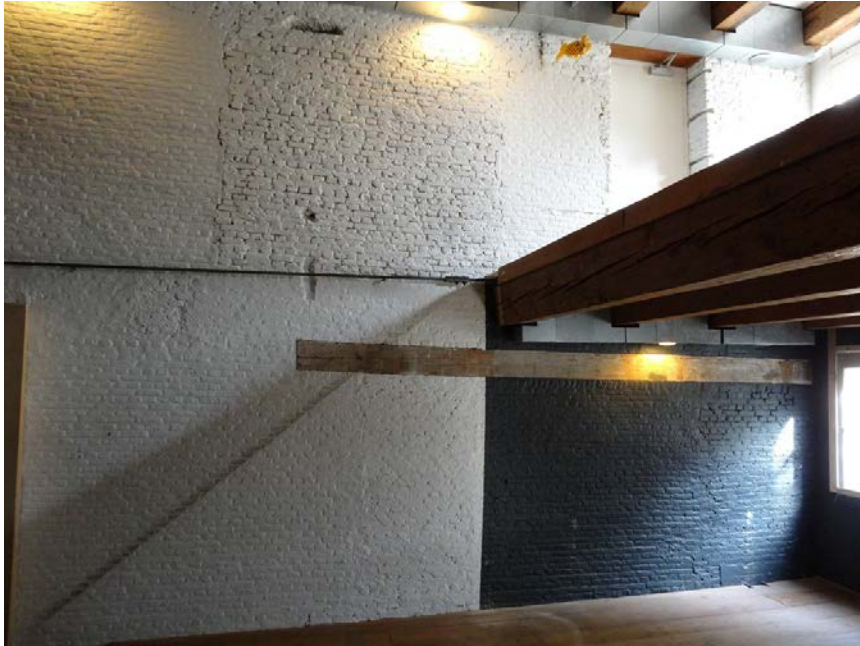
Afb. 33: Zuidelijke zijde van de tussenmuur op de tweede bouwlaag met rechts de oostelijke gevel. Onder de ingemetselde latei dichtzettingen met stroomlagen. Op de latei afwisselend schoon metselwerk en vuilwerk om de vloer op hoogte te brengen. Op het vloergedeelte van de derde bouwlaag de opening, waarvan de dagkantbetimmering ontbreekt. Naast de vloer een brede dichtzetting.
