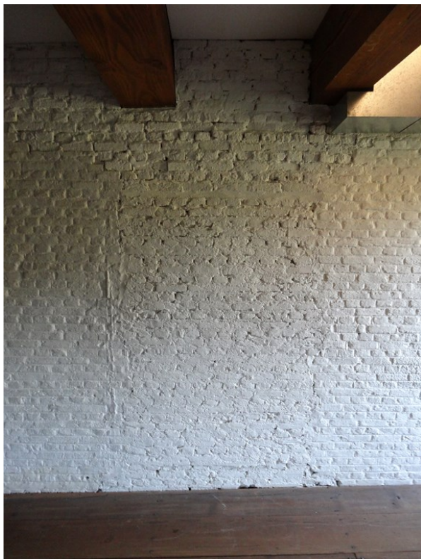
Afb. 39: Metselwerk aan weerszijden van een dichtzetting op de vierde bouwlaag, waarvan de onderste lagen in een plattere steensoort zijn gemetseld dan daarboven.
