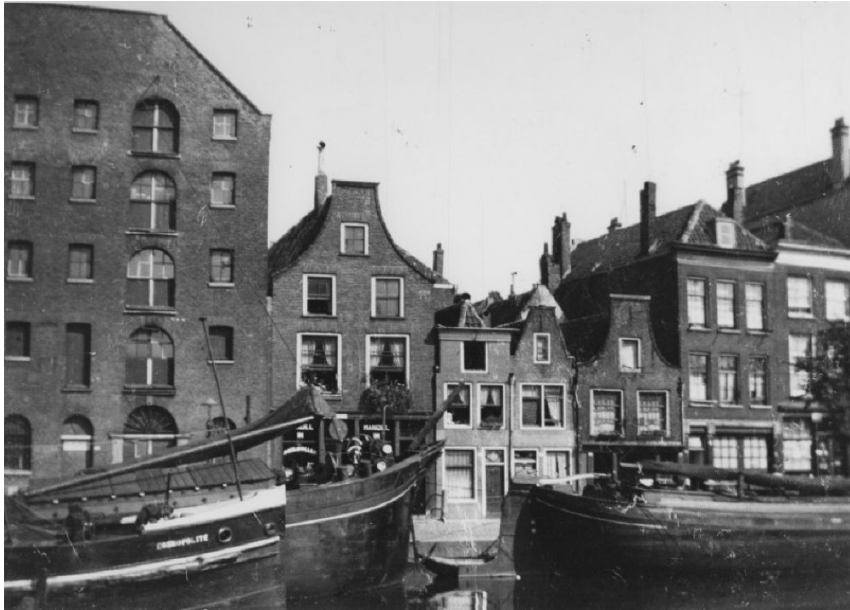
Afb. 10: Pakhuis in 1928 met de afgeknotte tuitgevel. Boven de rechter vensteras ontbreekt de hijsbalk. Ook het oculus is niet aanwezig. Bij na alle bovendeuren van de openingen in de centrale vensteras bezitten 4-ruits ramen.
