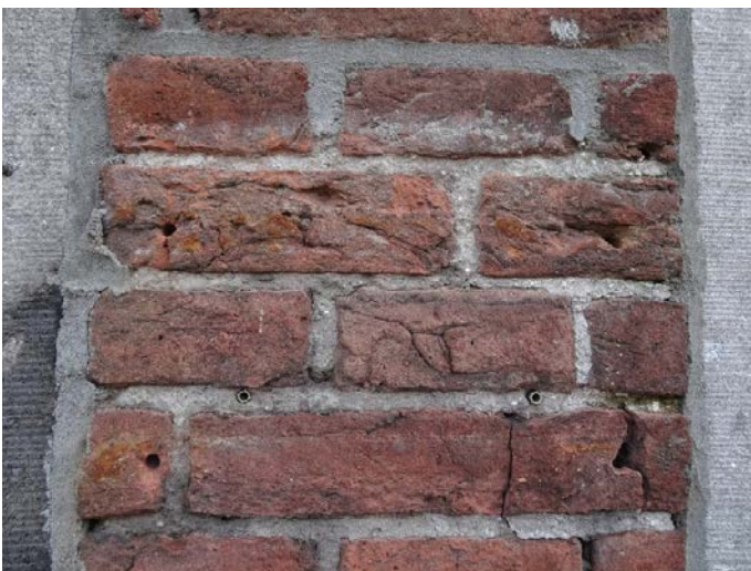
Afb. 16: Gevelmetselwerk tussen twee pilaren met twee lagen oorspronkelijk voegwerk.
