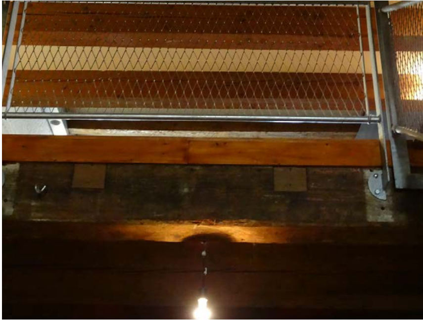
Afb. 31: Uitsparingen in de balken langs de vloerrand. Enkele sparingen zijn t.b.v. de hellingbanen tijdens de restauratie hergebruikt.
