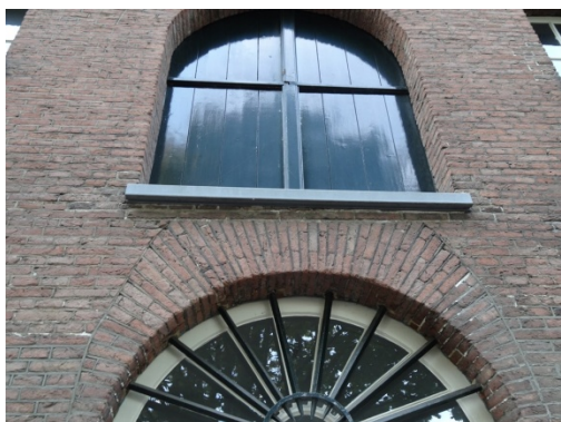
Afb. 23: bovenlicht van de centrale poort met radiale roedenverdeling en dito diefijzers. De rondboog wordt beëindigd met een parabolisch verlopende rollaag.
