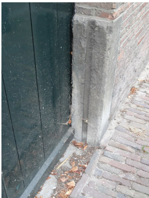
Afb. 24: Hardstenen aanrijsteen met sponning t.b.v. waterkering.
