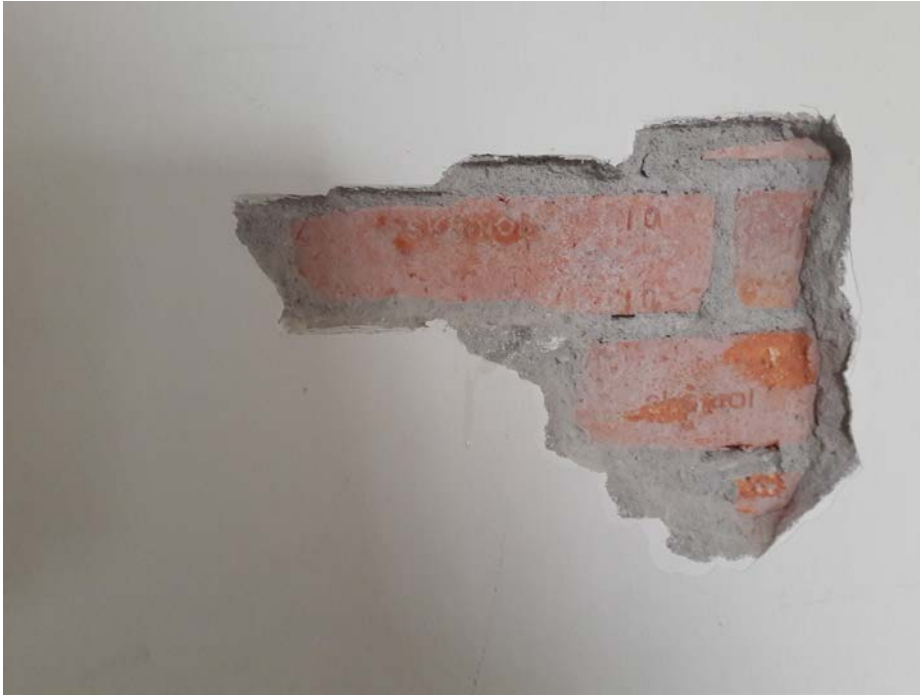
Afb. 27: Afgehakt pleisterwerk met modern metselwerk in halfsteens verband in de tussenmuur van de zuidelijke beuk.
