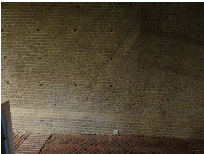
Afb. 29: Zuidelijke zijde van de tussenmuur met de afgeschuinde versnijding. In de lagen rondom de onderste gaten rij correcties van de lagen.
