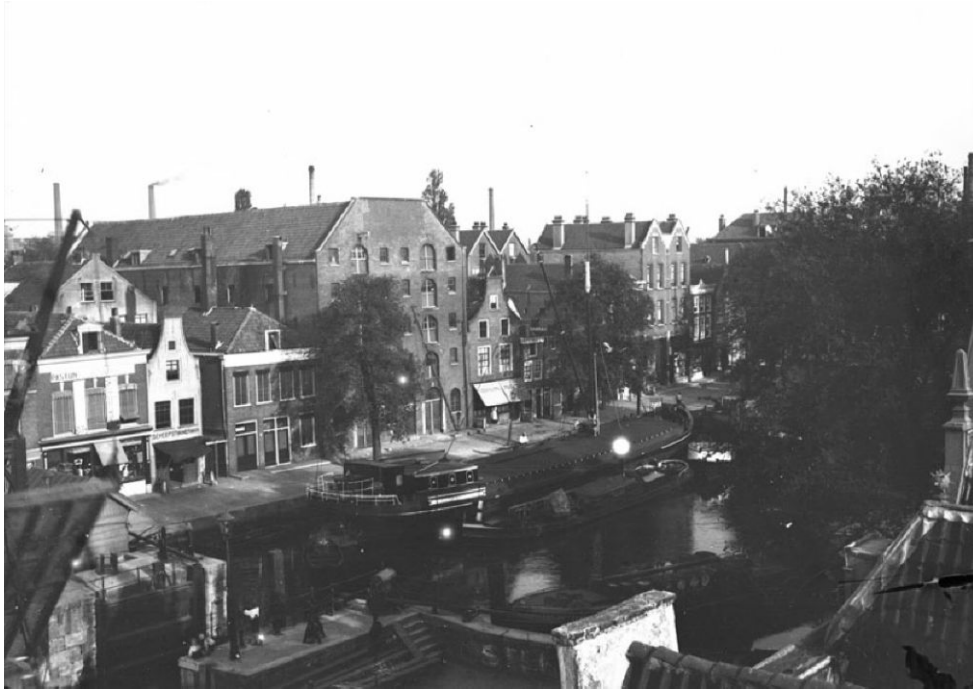
Afb. 8: Pakhuis "Dubbelde palmboom" in 1913 vanuit het noordwesten gezien. Ook de gevel aan het Piet Heynsplein (Achterhaven) heeft dezelfde gevelvorm. In de zijgevel zijn op regelmatige afstanden gevelopeningen zichtbaar. Op de dakvoet zijn kapellen geplaatst.
