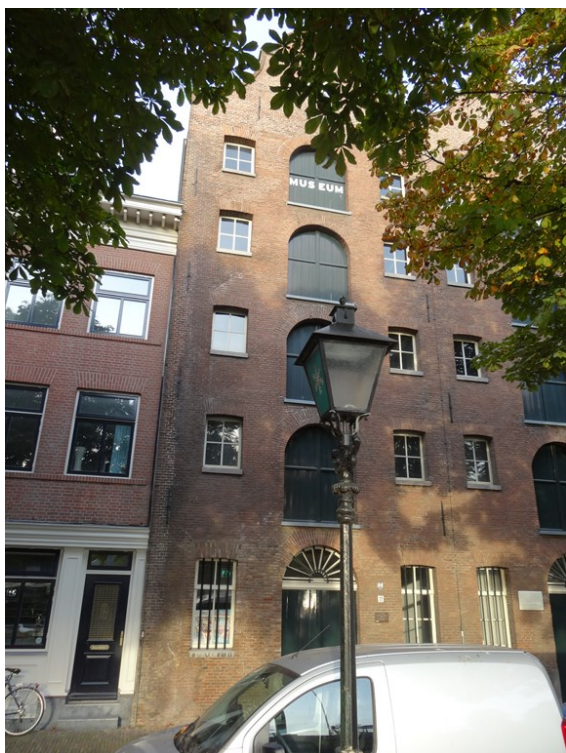
Afb. 20: Zuidelijk gedeelte van de oostelijke gevel.
