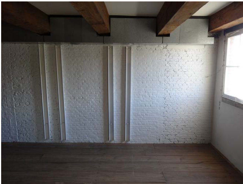
Afb. 32: Noordelijke zijde van de tussenmuur op de tweede bouwlaag ter hoogte van de lift, waarvan de verankering op de muur zichtbaar is. De beëindiging van het metselwerk rechts naast de tweede balk bezit drieklezoren in de koppenlagen.
