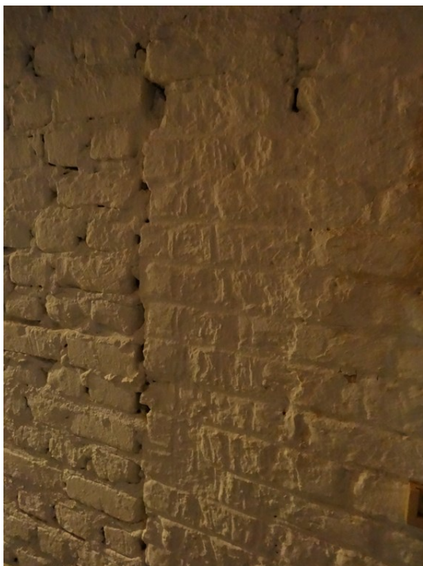
Afb. 38: Detail van de rechter aansluiting, waarin de beitelslag zichtbaar is.
