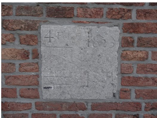
Afb. 18: Onder het venster is een memoriesteen aangebracht waarop extreem hoge waterstanden staan aangegeven, die van 1825 en 1776.
