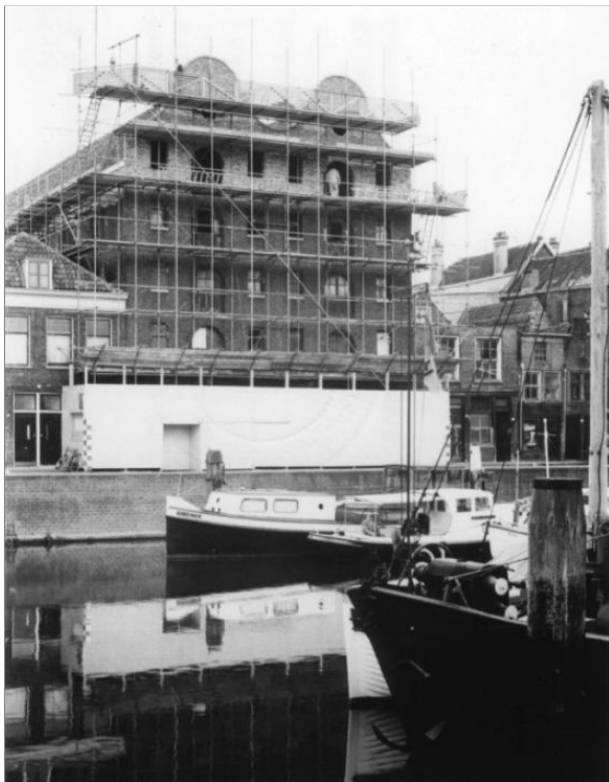
Afb. 11: Restauratie in 1973 van de "Dubbelde Palmboom" in volle gang. Tussen de steigers door is de gewijzigde topgevel zichtbaar als een gekoppelde klokgevel.
