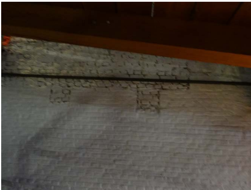
Afb. 34: Dichtgezette balkopleggingen in het schalmgat ter hoogte van de vloer van de derde bouwlaag. Het vloergedeelte moet bij gelijke balkhoogte scheef hebben gelegen.
