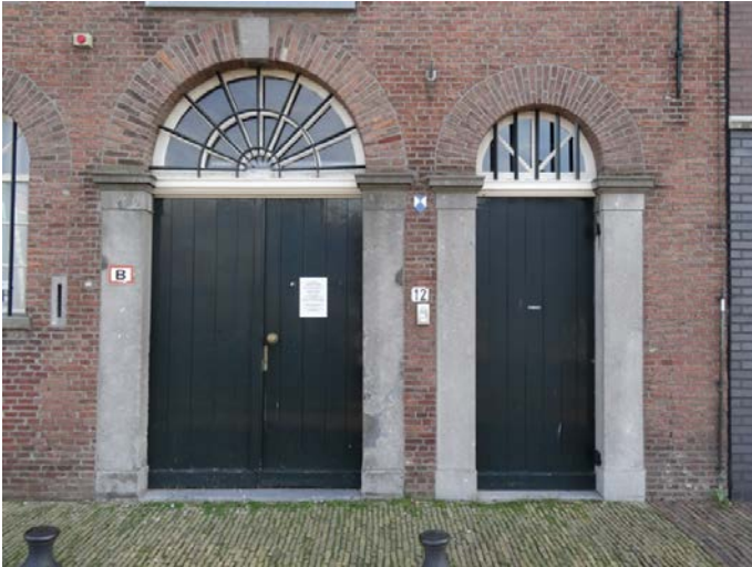
Afb. 14: Zuidelijk gedeelte van de gevel aan de Voorhaven met de twee poorten. De smalle poort is tijdens de restauratie aangebracht, ook met hardstenen pilaren en een naar buiten draaiende deur.
