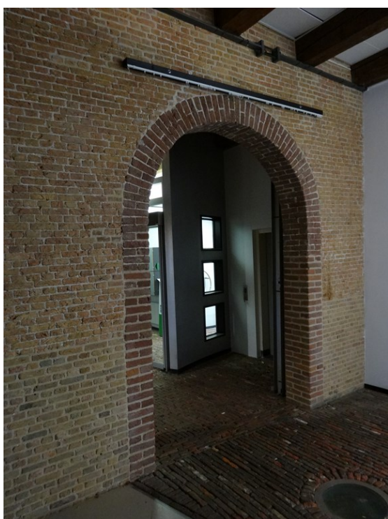
Afb. 30: Rondbogige doorgang in de tussenmuur, afgezet met paarse bakstenen. De rodere bakstenen met dikkere voegen zijn tijdens de restauratie vervangen evenals het metselwerk ernaast met de grijze voegen.
