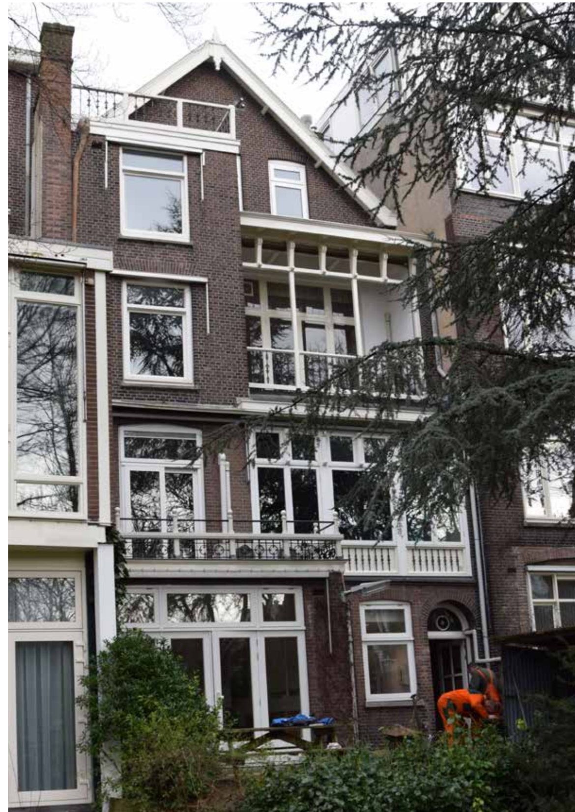
Foto achtergevel <Flexus AWC>
