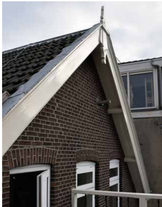
Balkon achteraanbouw <Flexus AWC>
