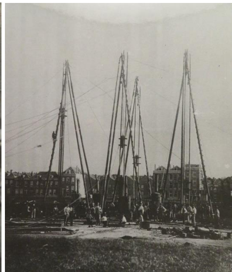
Zomer 1931; het bouwterrein wordt omheind en de eerste paal wordt geslagen. (Heinekencollectie)
