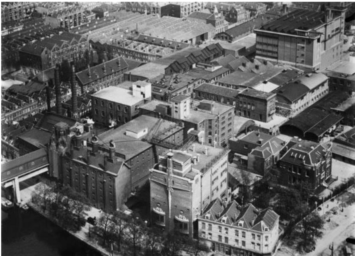
Luchtfoto uit omstreeks 1930 met de voltooide transportbrug, silo en ziederij op de voorgrond. (www.pinterest.nl)
