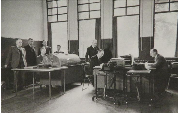
Foto van een onbekend kantoor. Aan de hand van de inrichting en de aanwezigheid van vier ramen is het waarschijnlijk het assistentenkantoor aan de westzijde van de bel-etage. (Heinekencollectie)
