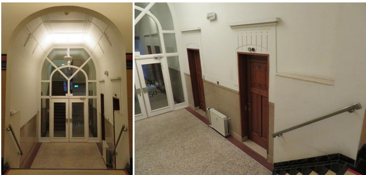
Centrale gang op de bel-etage tussen het bouwdeel uit 1932 en de brandwerende pui.
