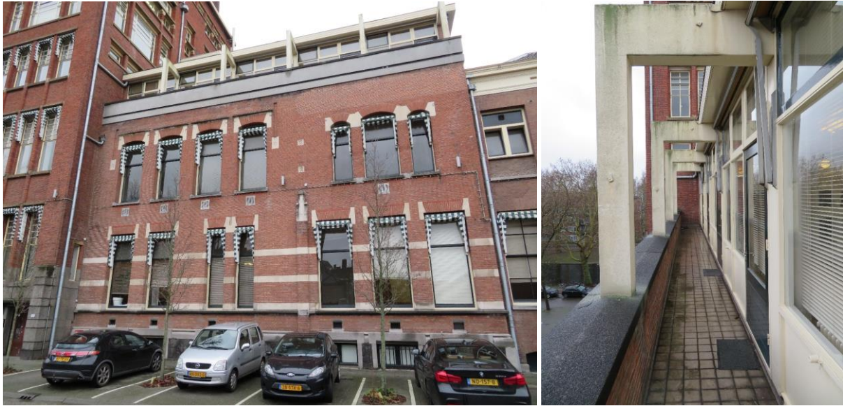
Oostgevel met balkon.
