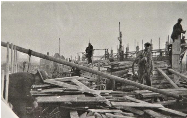
Winter 1931-1932; het maken van het dak van de vleugel. (Heinekencollectie)
