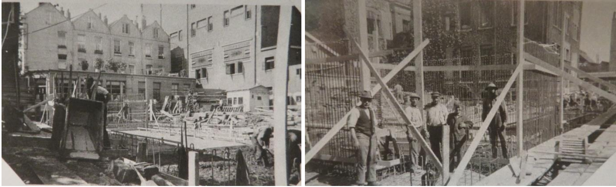
Najaar 1931; het bekisten en storten van de souterrainvloer en de kluiswanden. Op de linker foto is de achtergevel van café Hollandia en de zuidgevel van de ziederij te zien. (Heinekencollectie)
