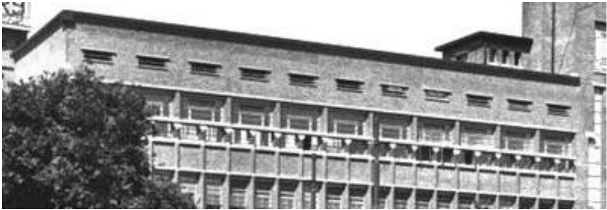
De zuidgevel, voor de wijziging van de derde verdieping, nog met kleine ramen. (Heinekencollectie)
