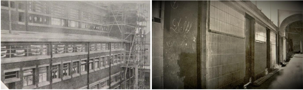
Voorjaar 1932; voltooiing van de noordgevel en een betegelde gangwand. (Heinekencollectie)
