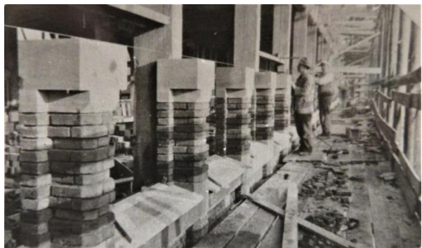
Winter 1931-1932; het optrekken van de zuidgevel, zichtbaar zijn de letters op niveau van de eerste verdiepingvloer en de gevelopeningen van de tweede verdieping. (Heinekencollectie)
