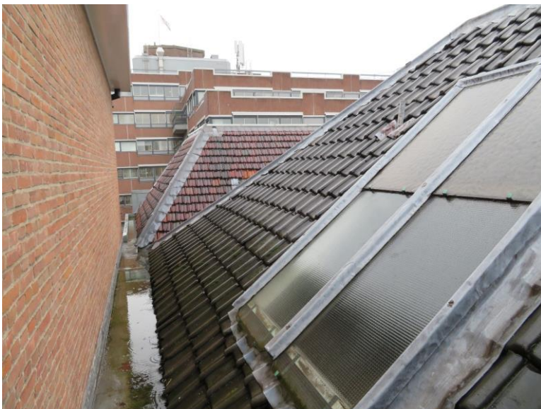
Dakvlak bouwdeel 1889 met daklicht.
