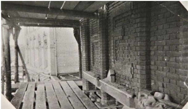
Winter 1931-1932; het optrekken van de zuidgevel, zichtbaar zijn de letters op niveau van de eerste verdiepingvloer en de gevelopeningen van de tweede verdieping. (Heinekencollectie)
