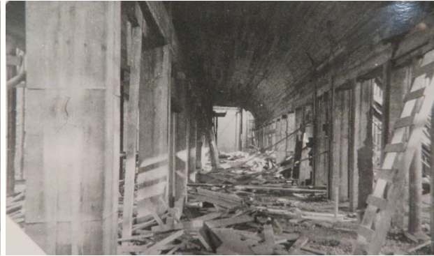
Najaar 1931; het betonskelet tot niveau van de tweede verdiepingvloer gezien vanaf de Crooswijksesingel en de gang op de eerste verdieping. Op de rechter foto is het gebogen plafond goed te zien. (Heinekencollectie)
