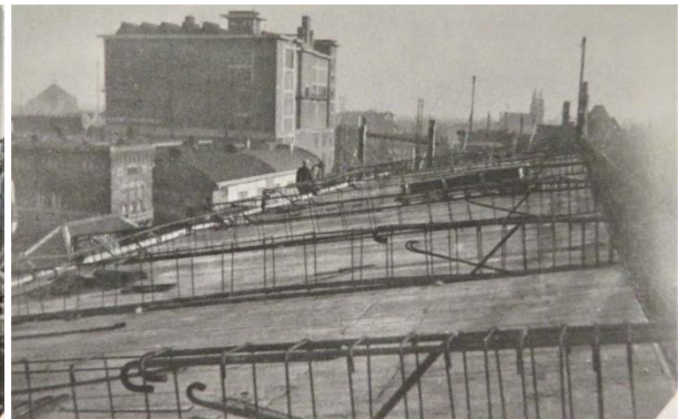
Winter 1931-1932; het optrekken van de zuidgevel, zichtbaar zijn de letters op niveau van de eerste verdiepingvloer en de gevelopeningen van de tweede verdieping. (Heinekencollectie)
