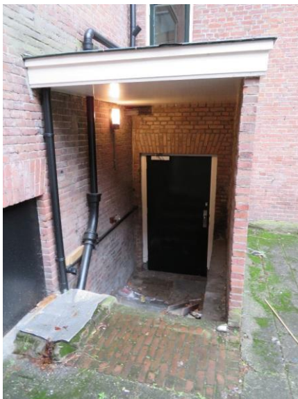
Portaal westgevel bouwdeel 1882.
