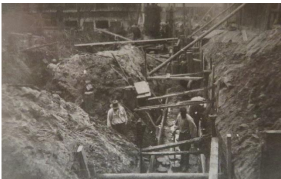
Zomer 1931; uitvoeren van het grondwerk en het maken van de fundering. Op de achtergrond is de zuidgevel van het bestaande kantoorgebouw te zien. (Heinekencollectie)
