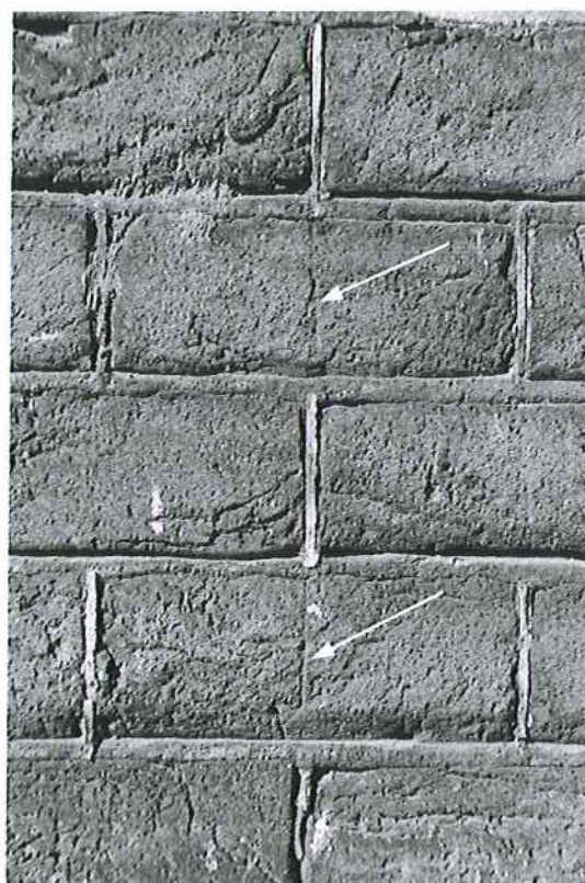
Afb. 15 Voorgevel. Detail van het voorgevelmetselwerk met kraslijnen (bij de pijlen) voor het zorgvuldig in verband metselen.
