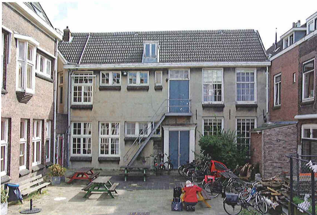
Afb. 22 De achtergevel van het huis, met rechts de achterzijde van de woningen aan de 2de Schansstraat (afb. 11) en links de zuidgevel van de vleugel uit 1924
