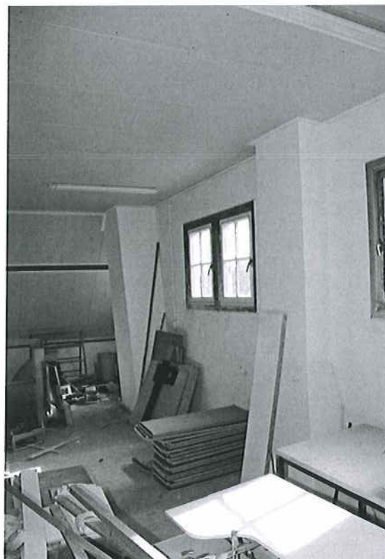
Afb. 64 Zolderruimte 2.24, gezien naar de zuidelijke topgevel (rechts) van het huis. Het linker schoorsteenkanaal hoort bij de schouw van kantoor 0.24 en eindigde vroeger bovendaks in een forse, fraaie schoorsteen. Het rechter kanaal diende ter ontluchting van de ondergelegen jongenslaapzalen (1.25 en 1.26).
