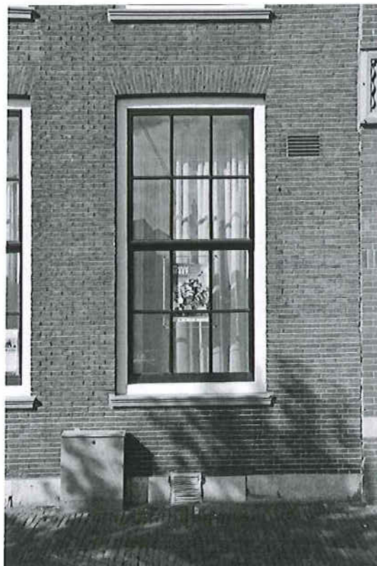
Afb. 19 Voorgevel. Venster op de begane grond uit 1872 en rechts de wat rommelige aansluiting tegen het rechts naastgelegen pand.
