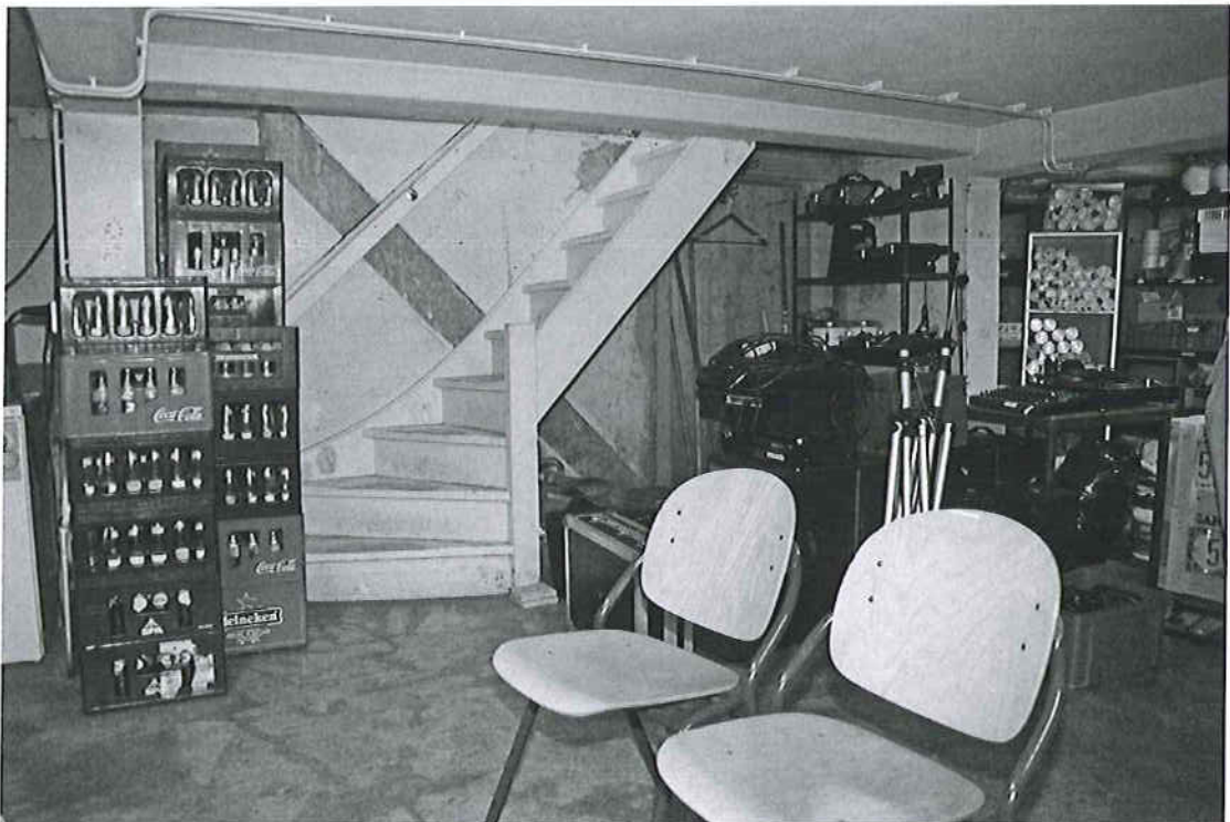
Afb. 30 De aan de westzijde gesitueerde provisiecellder in de vleugel uit 1924.
