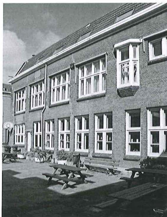
Afb. 25 De binnenplaatsgevel (zuidgevel) van de vleugel uit 1924.
