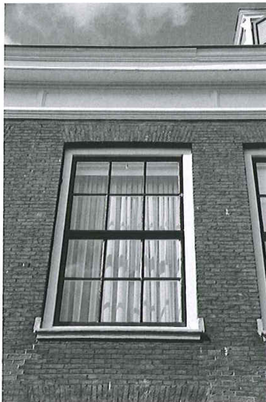
Afb. 18 Voorgevel. Venster op de verdieping met loodslab op de onderdorpel.
