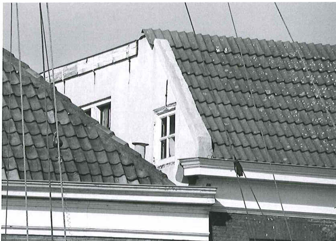
Afb. 20 Zuidelijke zijgevel. Topgevel met de rommelige aansluiting op de plaats waar voorheen op het nokeind een forse schoorsteen stond. Het kleine kozijn - met er midden boven een anker - dateert vermoedelijk nog uit de 18de eeuw.
