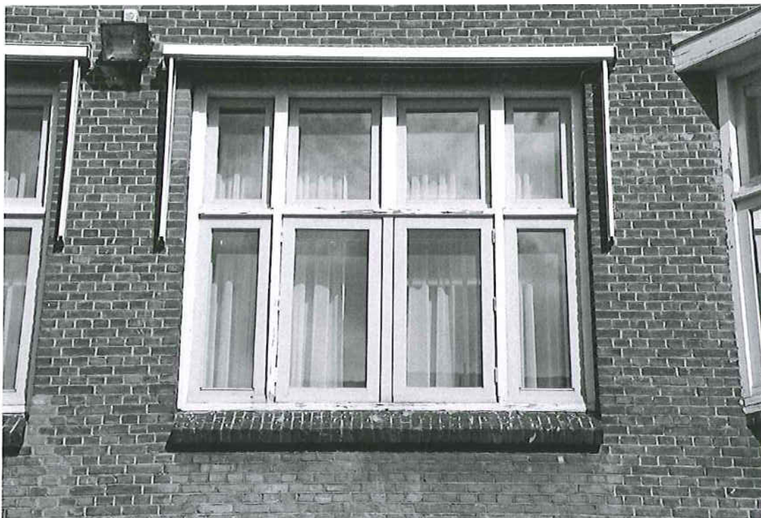
Afb. 26 Zuidgevel vleugel 1924. Samengesteld venster op de verdieping.
