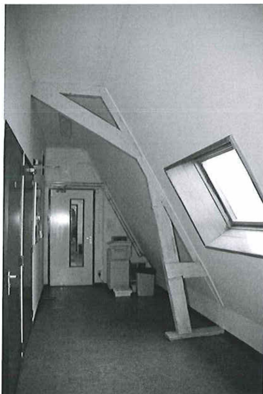
Afb. 70 De zolder van de vleugel uit 1924 met spant-been van een Hollands spant (ruimte 2.04).
