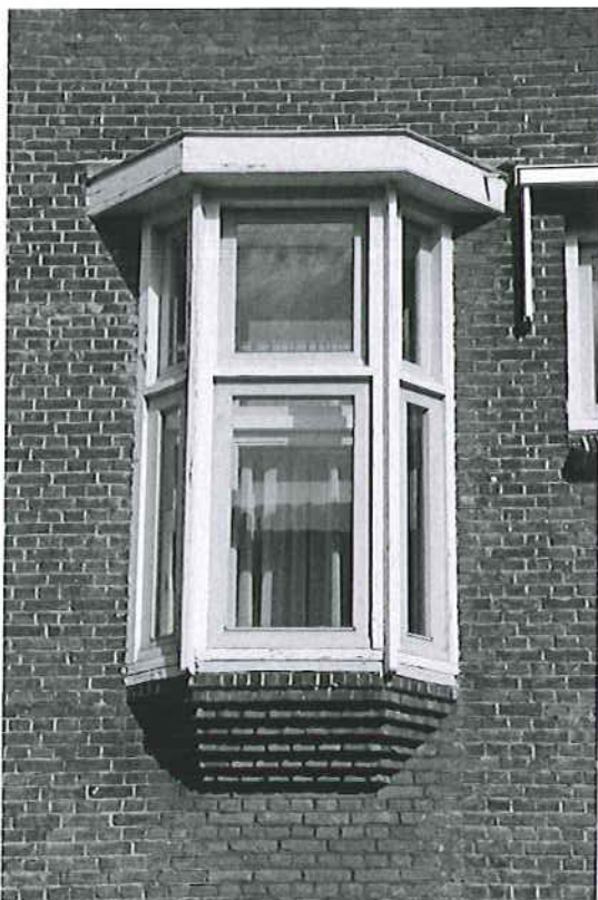
Afb. 27 Zuidgevel vleugel 1924. De erker op uitkragend metselwerk van de Kamer Juffrouw (tekening 1923, afb. 8b) had een goed uitzicht op de speelplaats.
