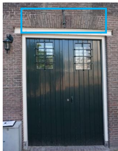
Strek van het voormalige venster in de zuidoostgevel
