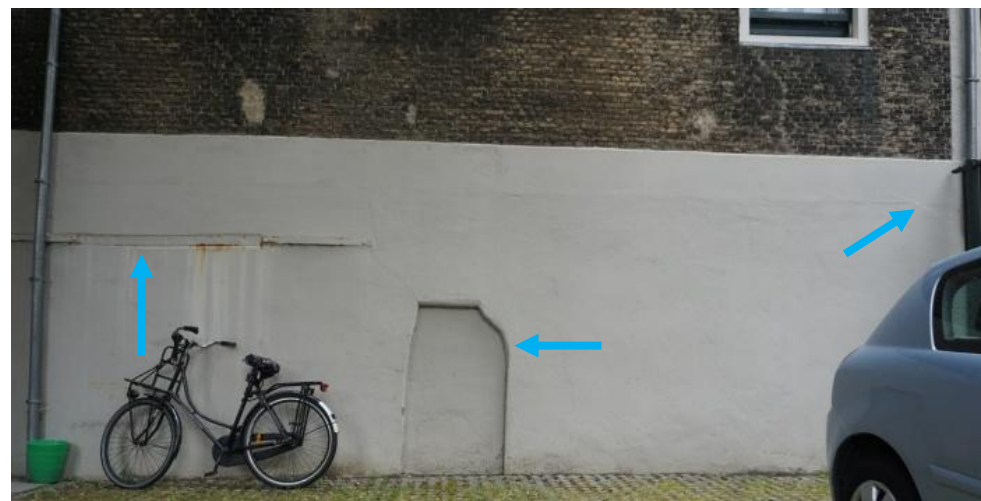
Sporen van ingangen in de noordwestgevel
