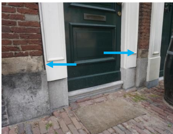
Aanpassingen in de plint bij de zuidelijke ingang in de zuidoostgevel
