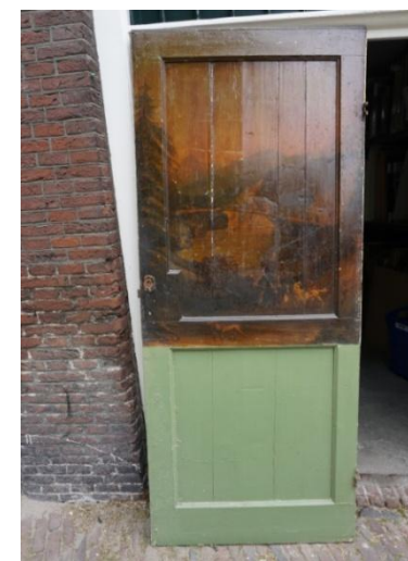
Opgeplaatte deur in 0.1
