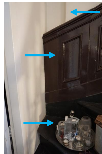
Naad in de trap en een verkenning in de muur in 0.2
