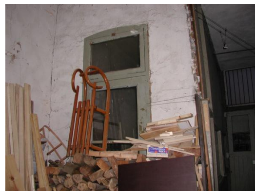
Kantoor op de begane grond (nu 0.5)
