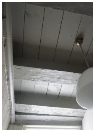
Afgehakte balklaag en hergebruikte balk links eronder in hal 0.1
