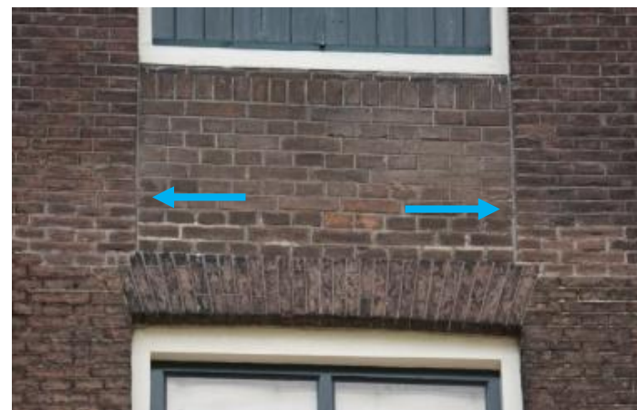
Naden van een grotere luikopening in de zuidoostgevel
