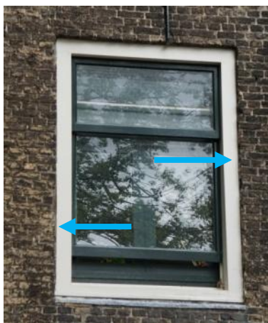
Onregelmatige dagkant in de noordwestgevel
