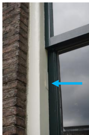
Aftekening van een ouder bovenraam in de zuidoostgevel
